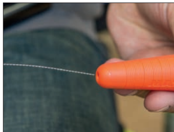
21. Enfilez le cable dans le pull bung
